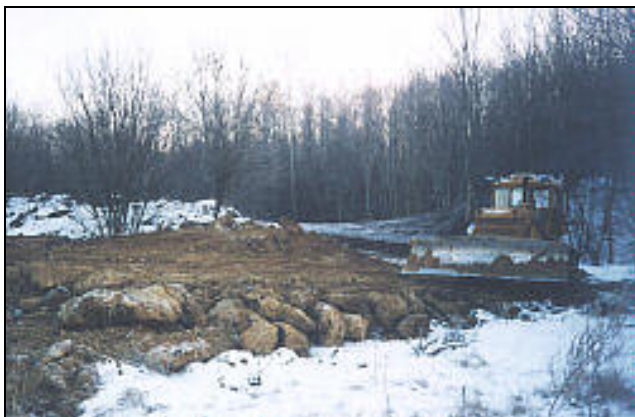
Tõstamaa valla prügimägi on nüüd suletud.
