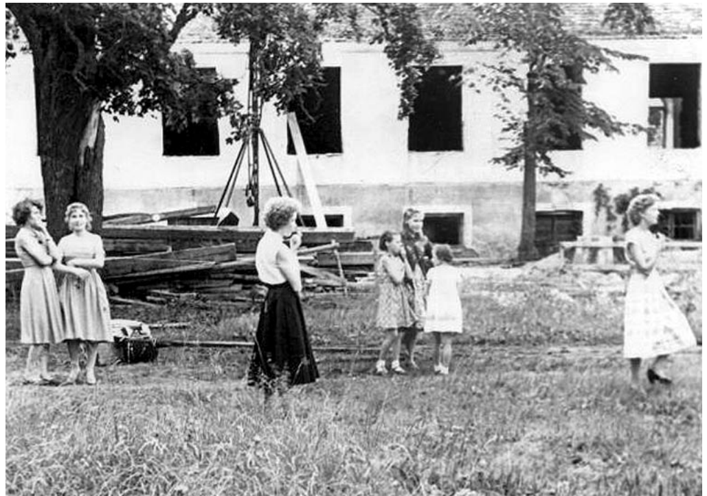
1961. aastal algas mõisa remont ning mõningane ümberehitus.
